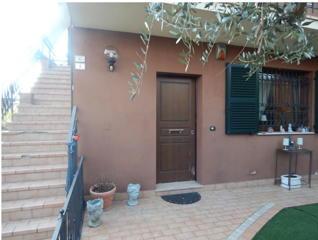
Foto n. 7 – Portone ingresso appartamento
