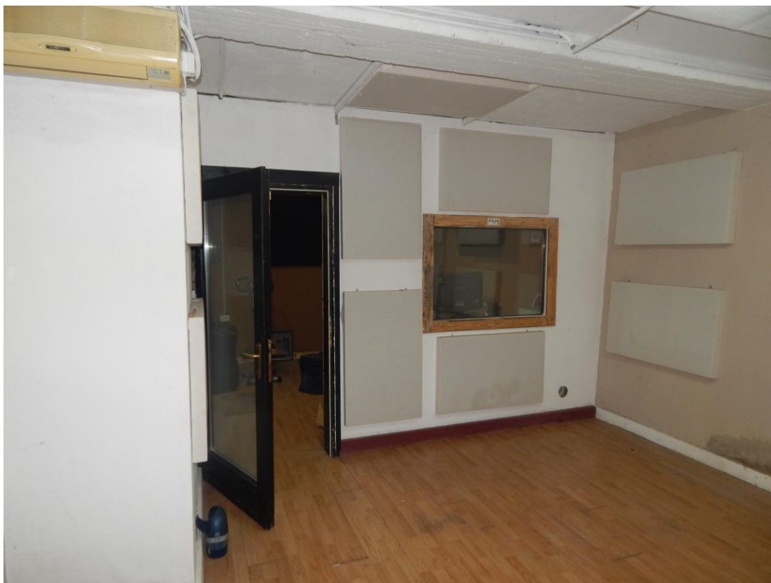
Foto n. 21 – Deposito piano interrato
